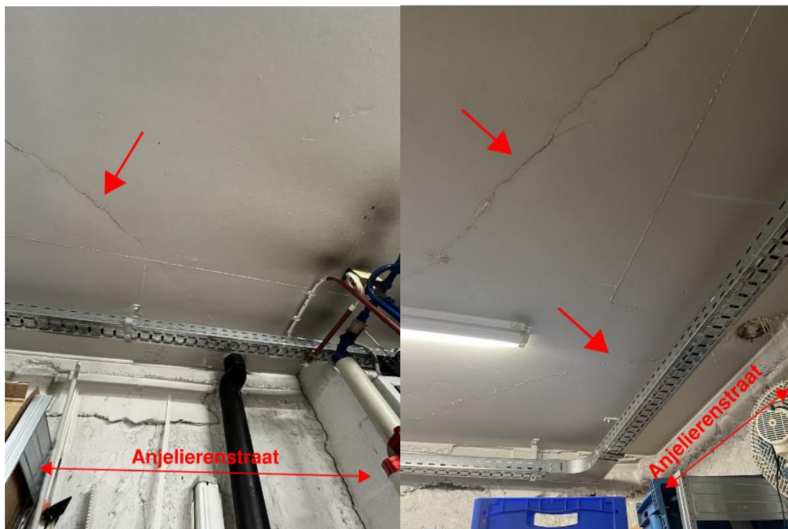
Schematische indicatie barstvorming afdek -2 - Anjelierenstraat ondergronds
